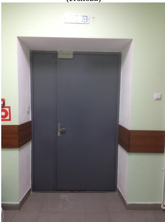
Фото №23 Пути эвакуации
