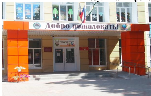
Фото №1 – Вход в здание
